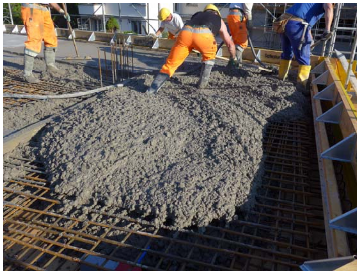
Figure 2: Travaux de bétonnage en été
