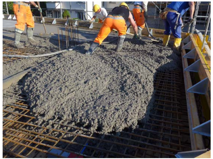
Abbildung 2: Betonierarbeiten im Sommer
