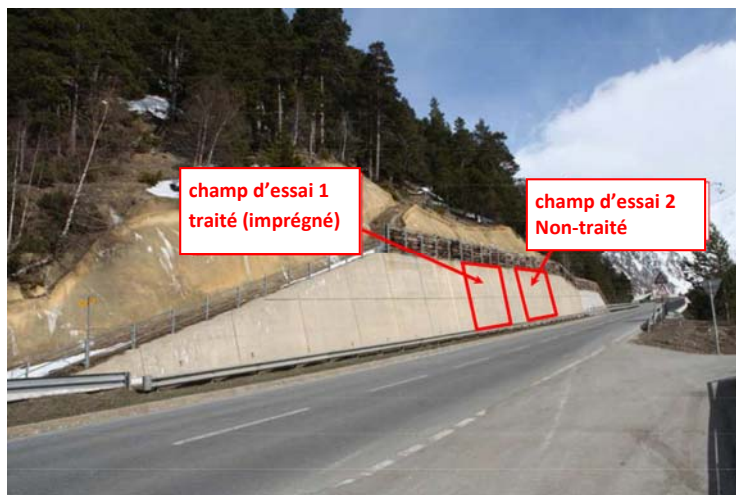
Fig. 3 : mur de soutènement Eisten avec champs d'essais 1 et 2
