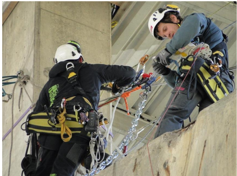
Abb. 5: Vorbereitung einer Potentialfeldmessung einer Autobahnbogenbrücke vor dem Gerüstbau
