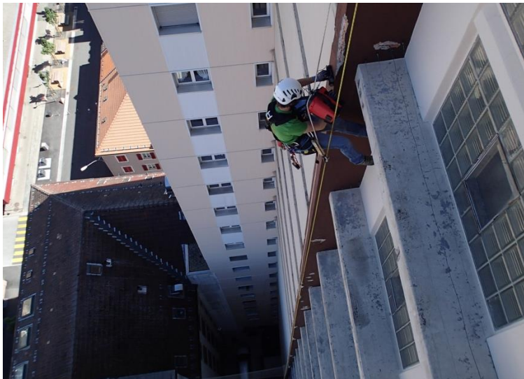
Abb. 3: Messung der Bewehrungsüberdeckung über die gesamte Fassadenhöhe von 60 m (Vertical access Särl)
