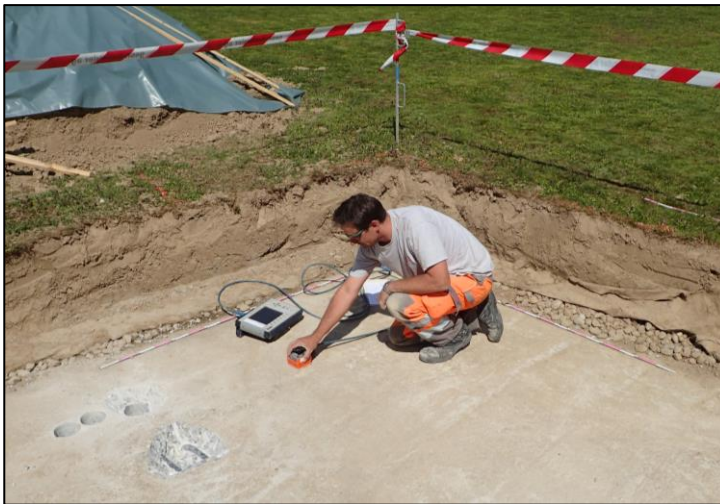
Abb. 1: Radarmessung auf einer Decke
