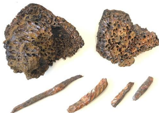
Abb.4: Knolle aus Korrosionsprodukten mit zelliger Struktur und stark korrodierte Bewehrungsstäbe aus der Sondage gemäss Abb.2
