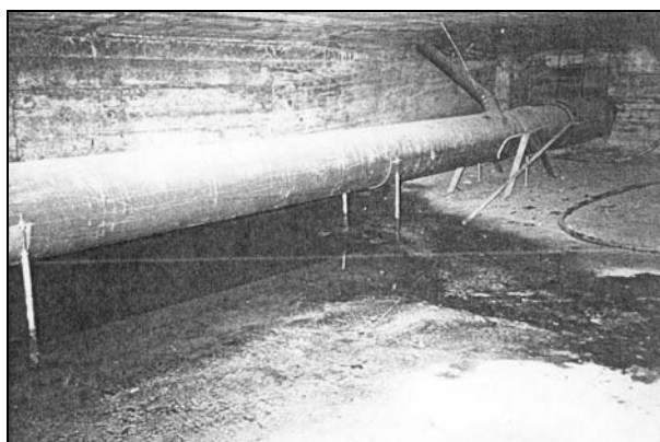
Bild 2.25 a) Undichte Entwässerungsleitung in einem Hohlkasten und b) Wassereintritt durch Elektro- rohre ( ZH-16 ).
