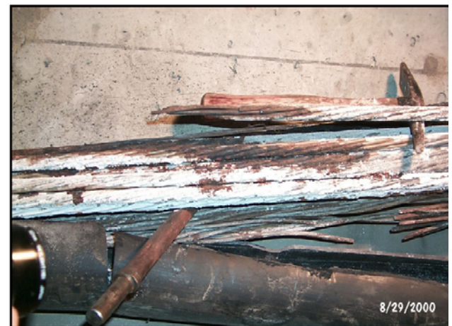
Bild 2.76 Korrosion an Ankerköpfen und Korrosionsschäden an den Litzen der Mid-Bay-Brücke [FDOT 2001b].
