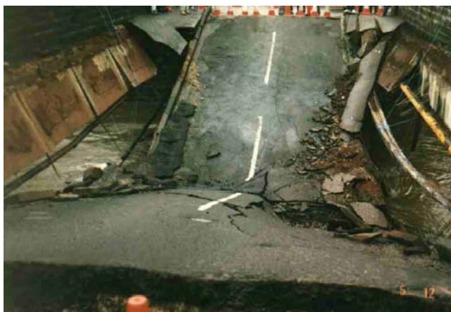
Bild 2.43 Ynis-y-Gwas-Brücke nach dem Einsturz 1985. Linkes Bild [PIARC 1999].
