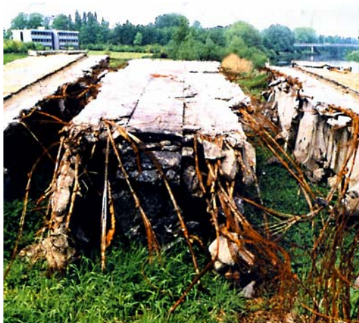
Bild 2.48 Details der Brücke über die Melle bei Gent, Belgien, nach dem Einsturz (Ministère Wallon de l'Équipement et des Transports).
