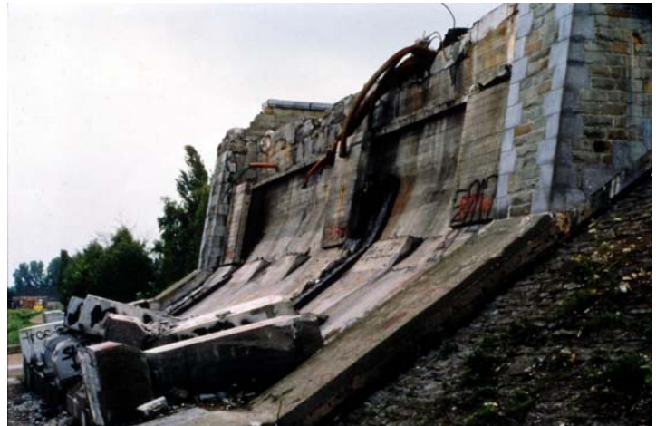
Bild 2.48 Details der Brücke über die Melle bei Gent, Belgien, nach dem Einsturz (Ministère Wallon de l'Équipement et des Transports).
