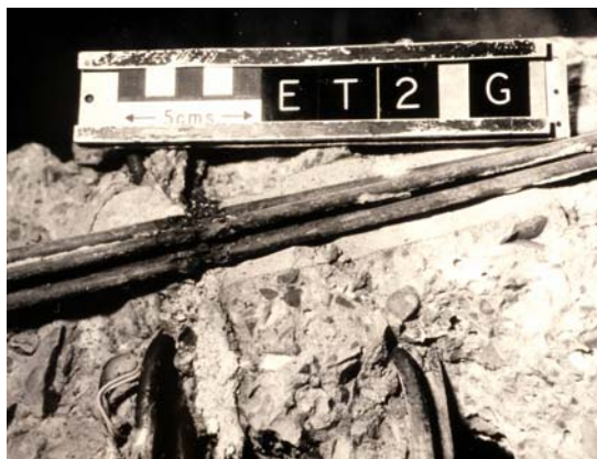
Bild 2.45 Korrosionsschäden am Spannstahl bei der Ynis-y-Gwas-Brücke [PIARC 1999].
