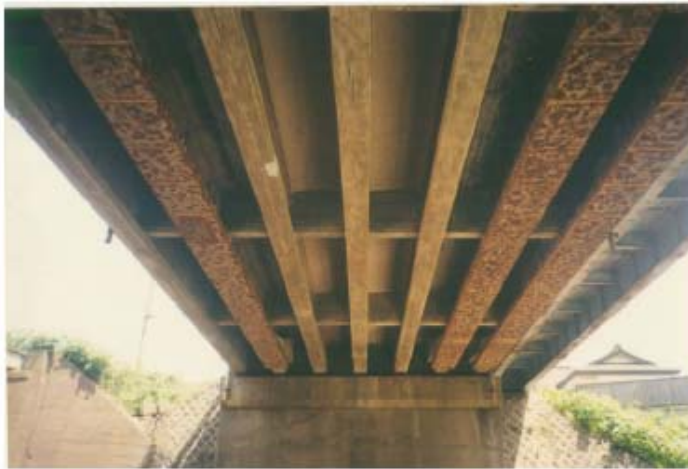
Bild 2.62 a) Einfluss der Distanz zur Meeresküste und des Alters auf das Schadenausmass bei vorgespannten Brücken [Mutsuyoshi 2004], b) Untersicht der Oyakawa-Brücke und c) Lage der Vorspannglieder (links) [Kondo 2002].
