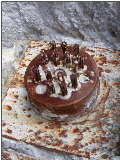
Bild 4.24 Risse im Beton einer Verankerung wegen der Alkali-Aggregat-Reaktion und dadurch Wassereintrag in den Ankerkopfbereich und Korrosion am Ankersystem.
