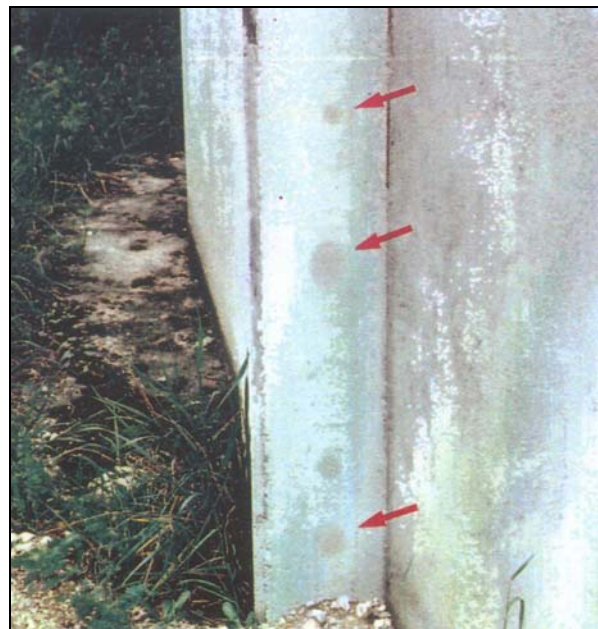
Bild 2: Dunkle Verfärbungen, „Fettflecken“ auf dem Mörtel der Ankerischen.
