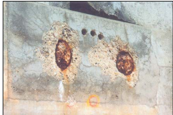
Bild 6: Verankerung der Querjoch.
