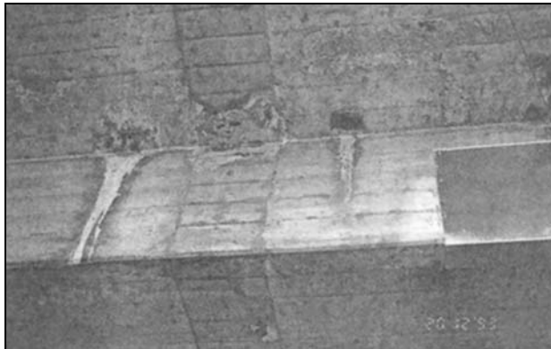
Bild 2: Spuren der Wasserläufe entlang der Stegaussenseite.
