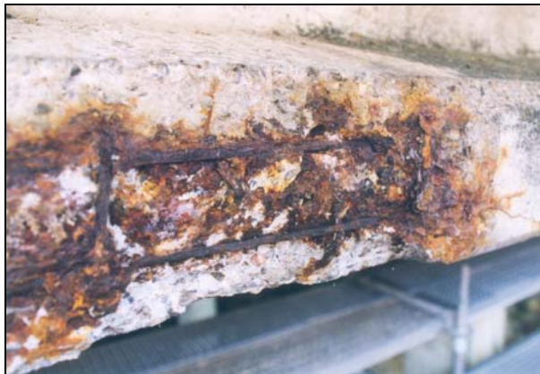
Bild 4: Starke Bewehrungskorrosion.
