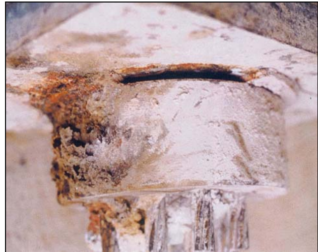
Bild 6: Spalt zwischen Ankerbüchse und –platte.
