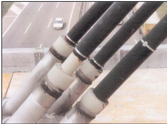
Bild 2: Muffenbereich unten.
