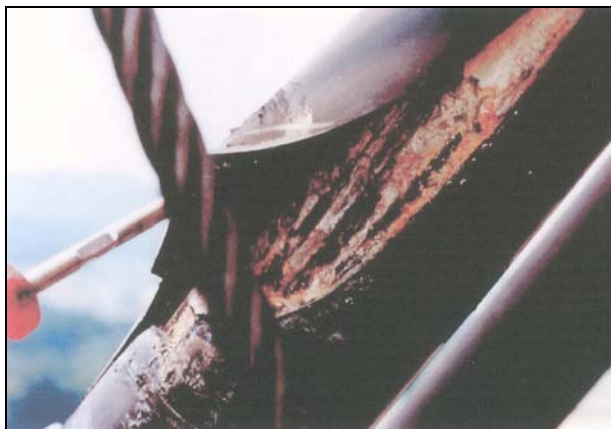
Bild 4: Öffnen des Spanngliedes.
