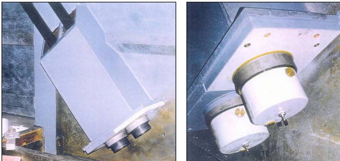
Bild 6: Unterer Verankerungsbereich (Schutzhauben mit Messanschluss).
