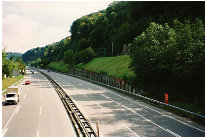
Bild 1: Blick auf die Pfahlwand Seite Bern mit oben liegender SBB-Linie Bern – Freiburg.
