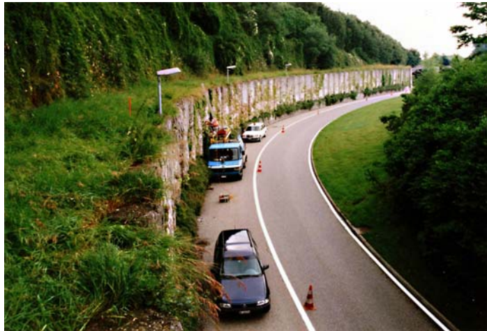
Bild 1: Blick auf die Pfahlwand und die darüber stehende bepflanzte Evergreen-Stützmauer.
