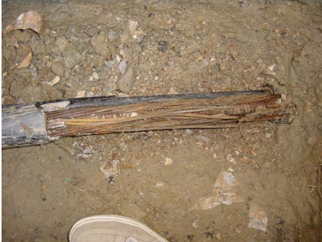
Bild 7: Sicht auf den freigelegten Anker Nr. 21 der Mauer Nr. 46.
