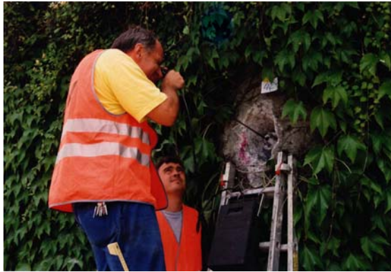
Bild 3: Inspektion des Bereichs hinter dem Ankerkopf mit Endoskop.
