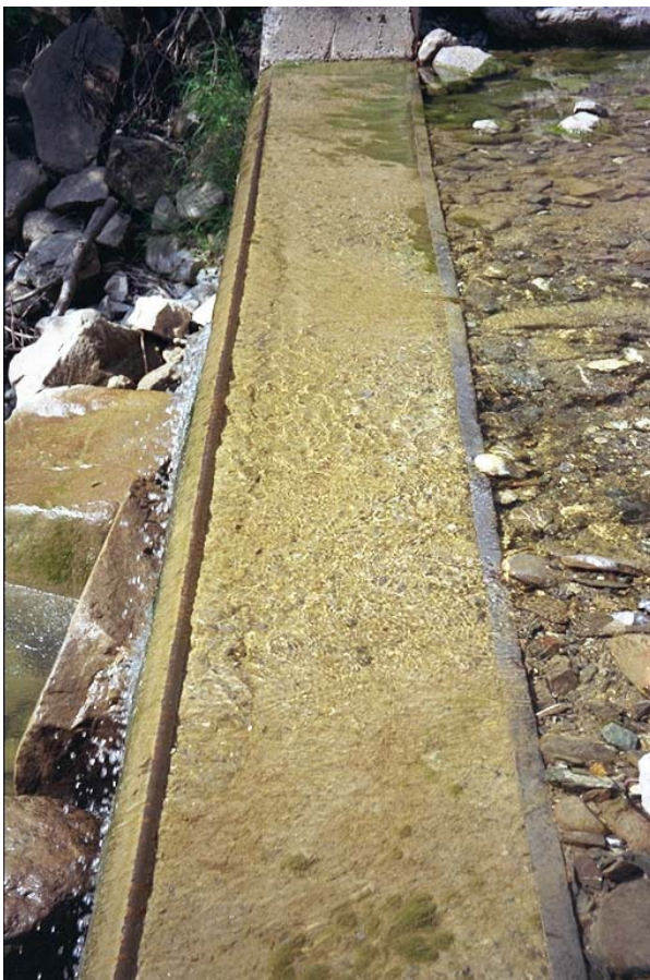
Abbildung 3.3: Muldenförmige Abrasion auf einem Wehrrücken;
