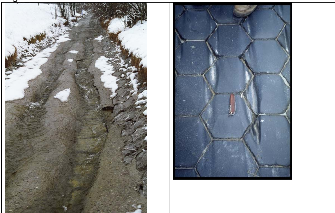
Abbildung 3.4: Linienförmige Abrasion in einem Gerinne mit Betonsohle (links) sowie abgeschliffener Schmelzbasalt (rechts)
