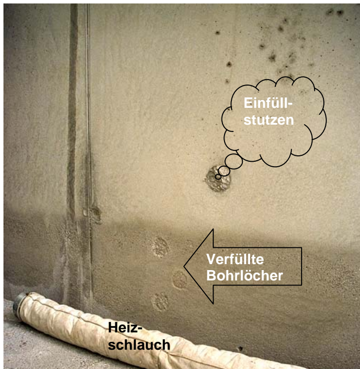
Abbildung 5: SCC-Konsistenz beim modifizierten Ausbreitmassversuch, d.h. ohne Verdichtung und Tischheben (oben) und ausgeschaltete Betonoberfläche mit davor liegendem Heizschlauch (rechts)
