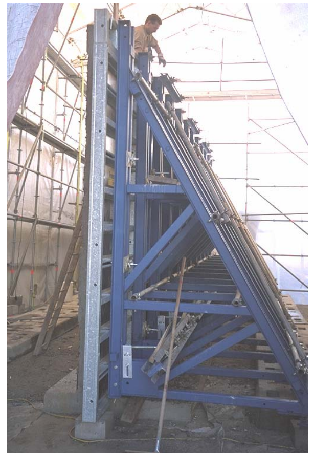
Abbildung 4: Höchstdruckwasserabtrag an der Versuchswand (rechts oben), Aufrichten der Schalung zum Vorbetonieren (rechts unten)
