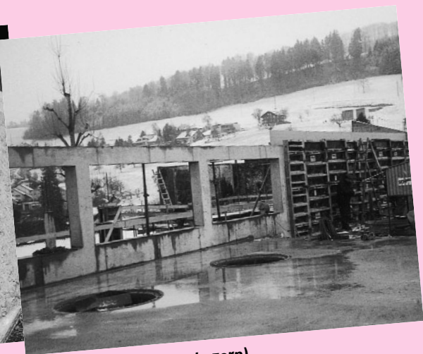
SCC-Sichtbeton (Raum Luzern)
